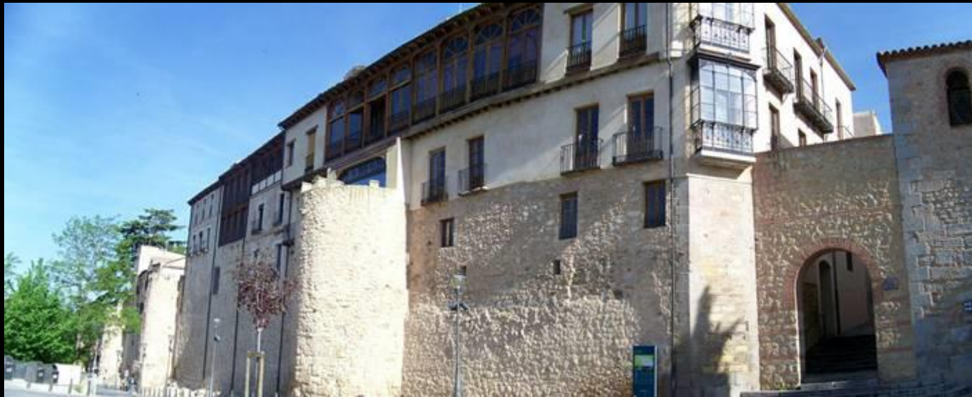
Puissance des remparts
